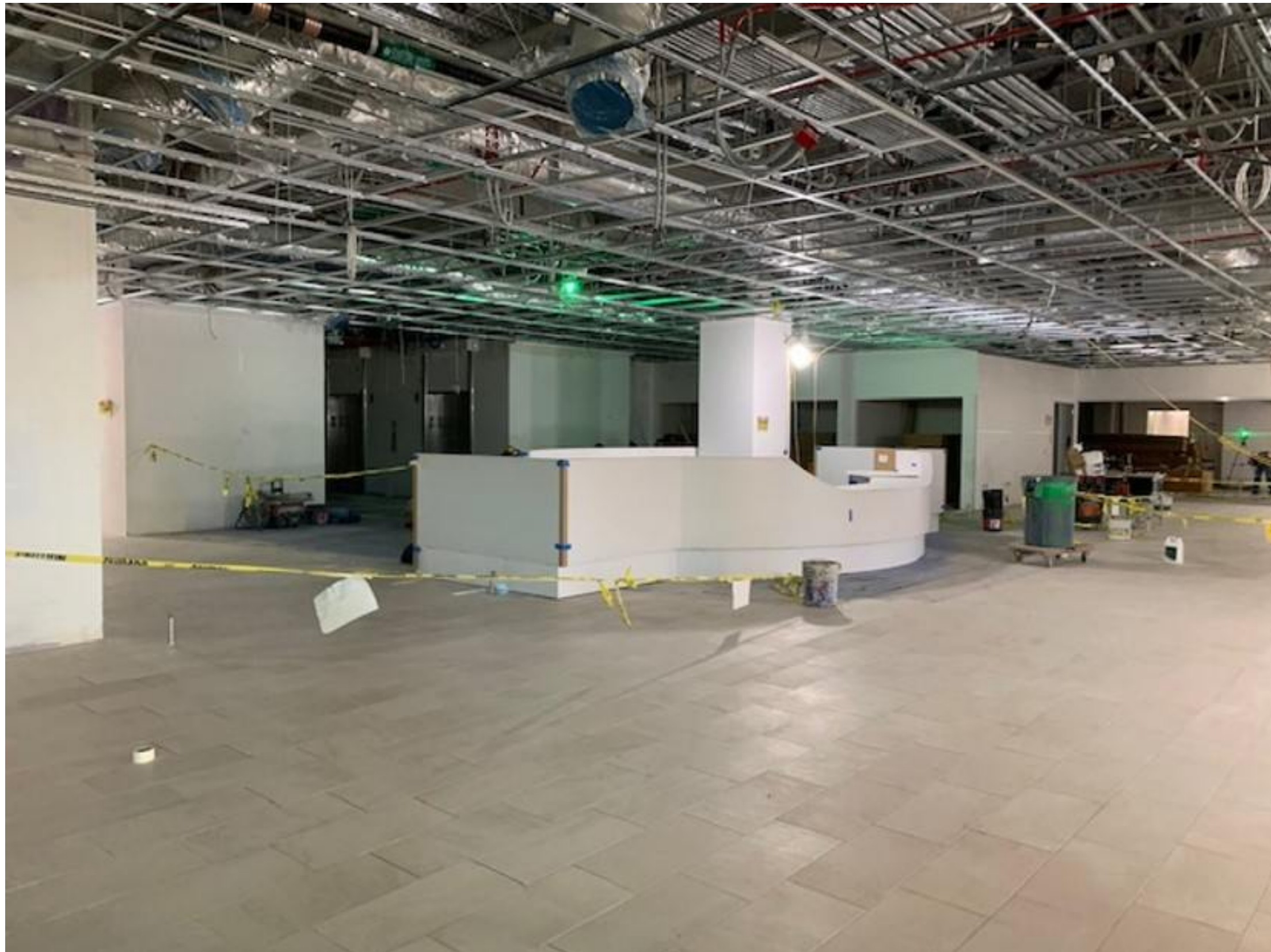
Sécurité du hall principal
