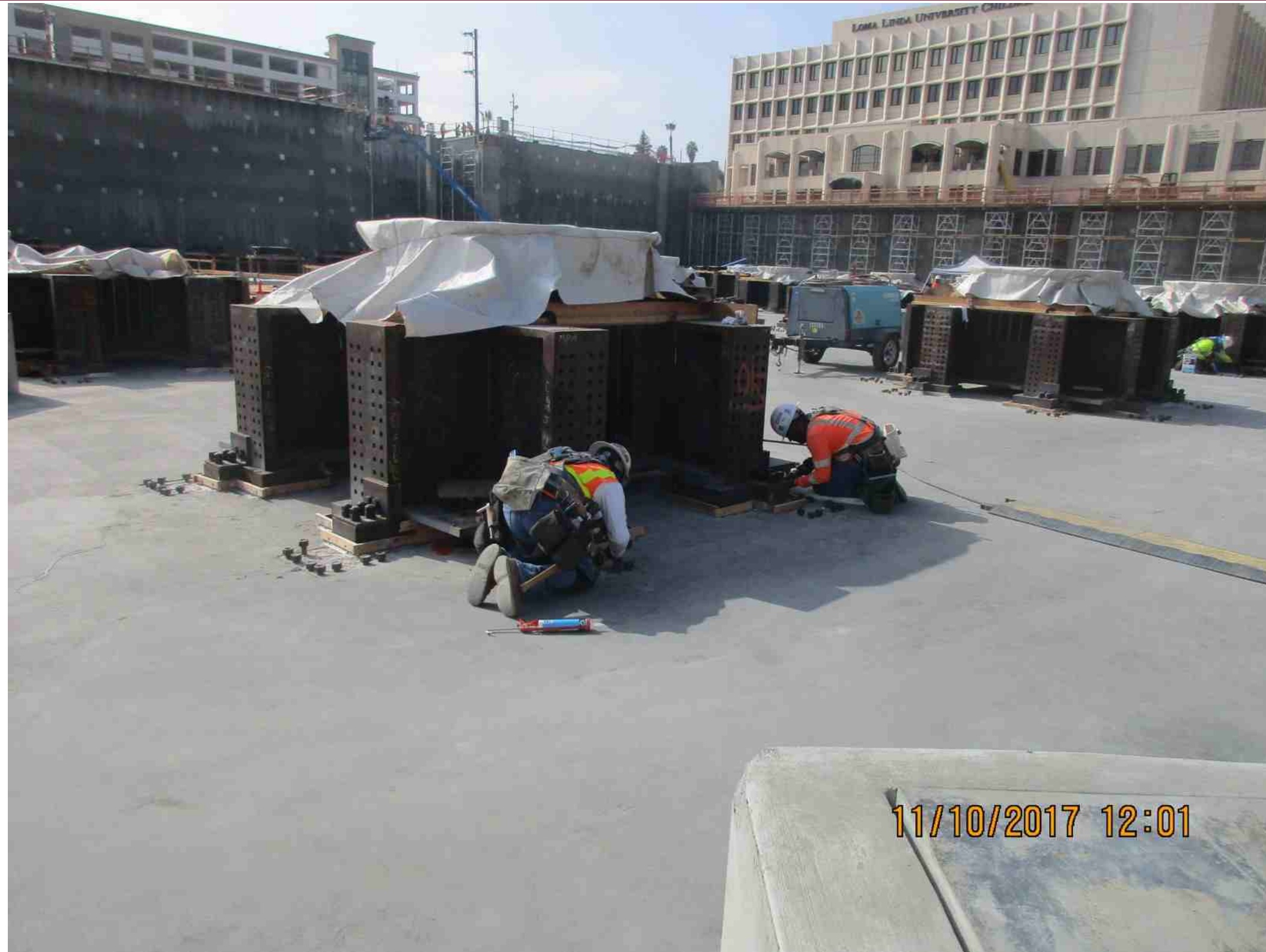
Jointoiement de socles sur la dalle
