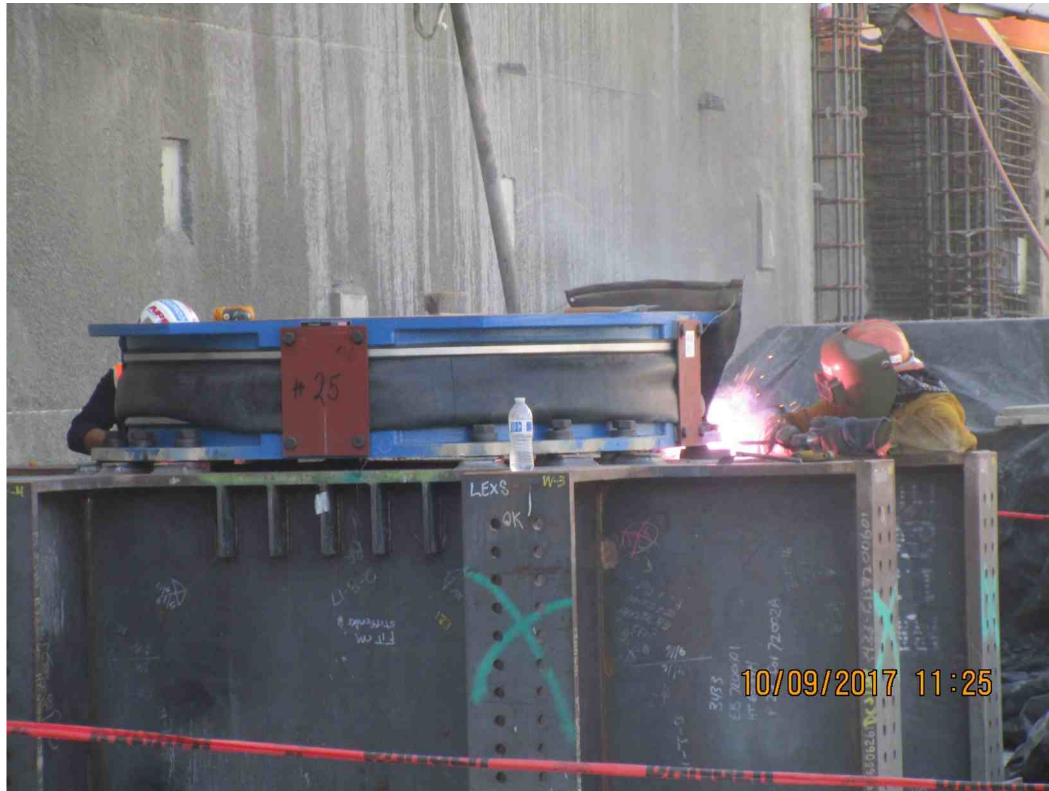
Préparation des isolateurs pour le jointolement
