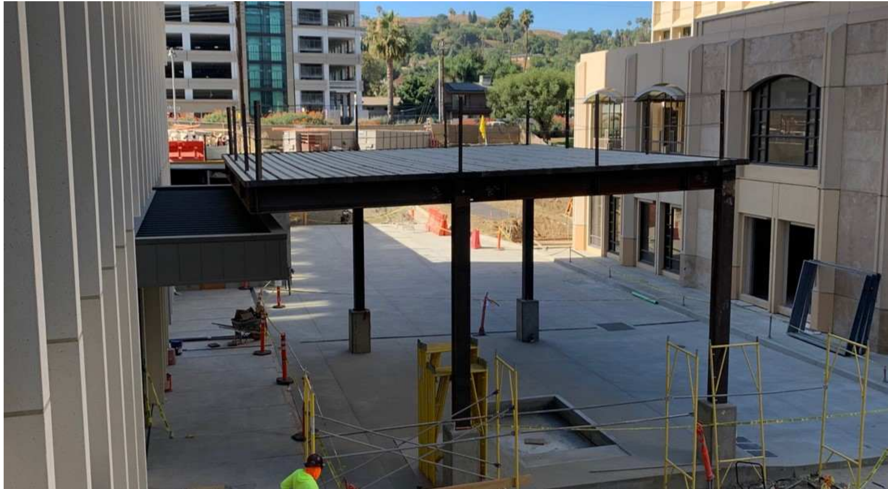
Quai de chargement
