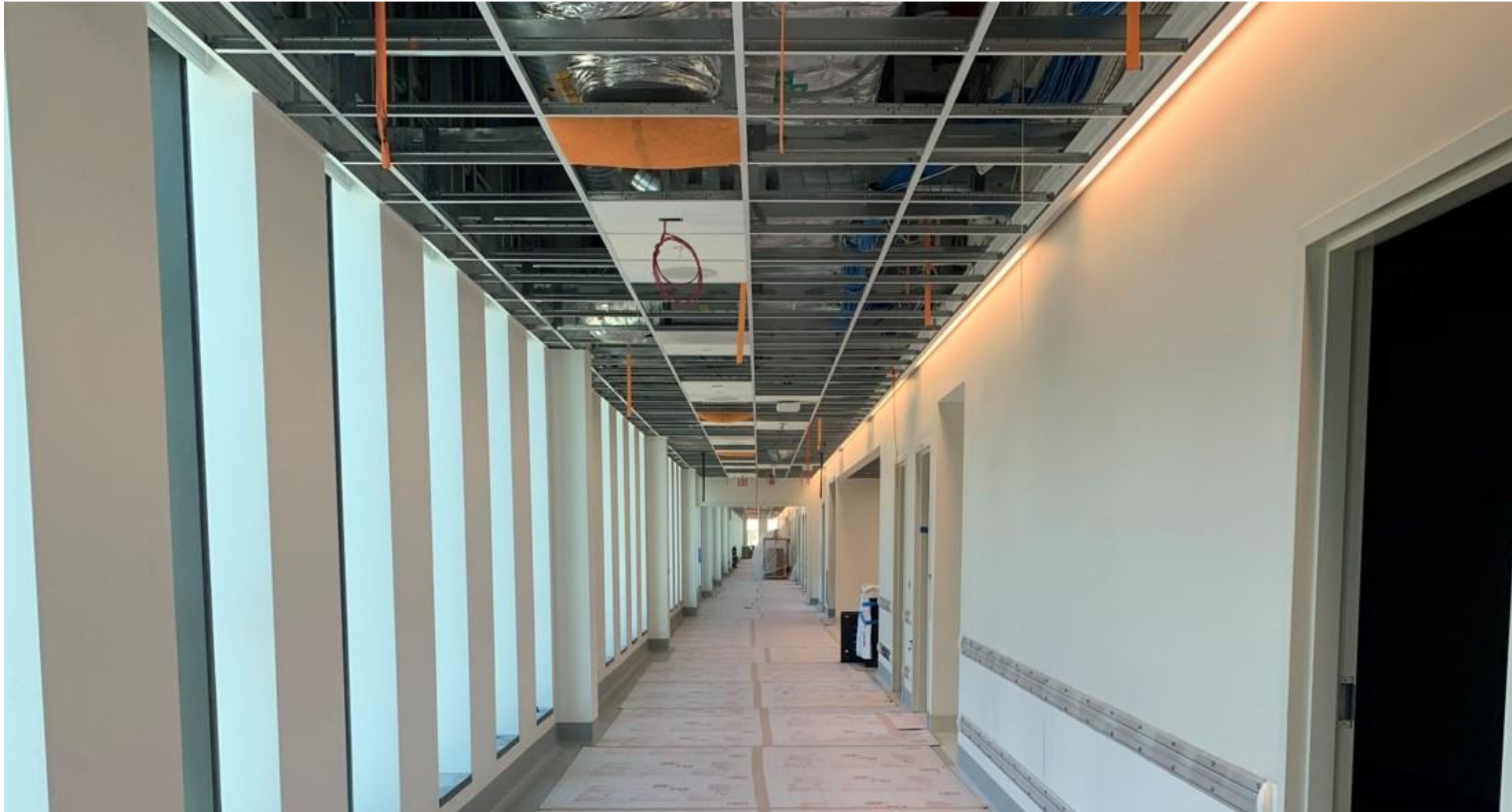
Couloir sud de la salle d'opération
